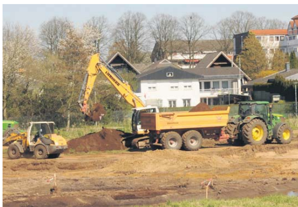
Auf der Wiese neben der Hudau werden Tümpel gegraben. Das Gelände soll bei Hochwasser überschwemmen.
