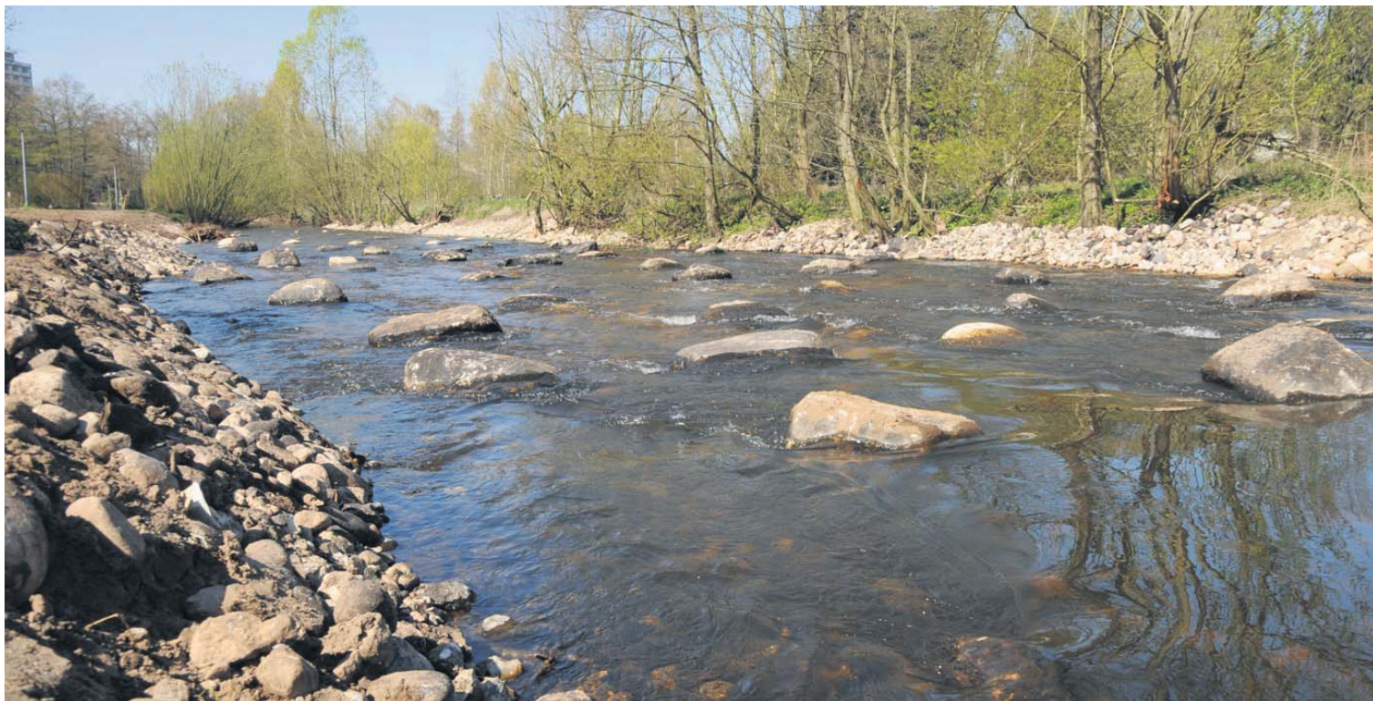
Die Solgleite in der Hudau in Höhe der Kneipp-Anlage hat ein deutlich flacheres Gefälle bekommen als die bisherige. Dadurch können kleine Tiere besser flussaufwärts schwimmen.
